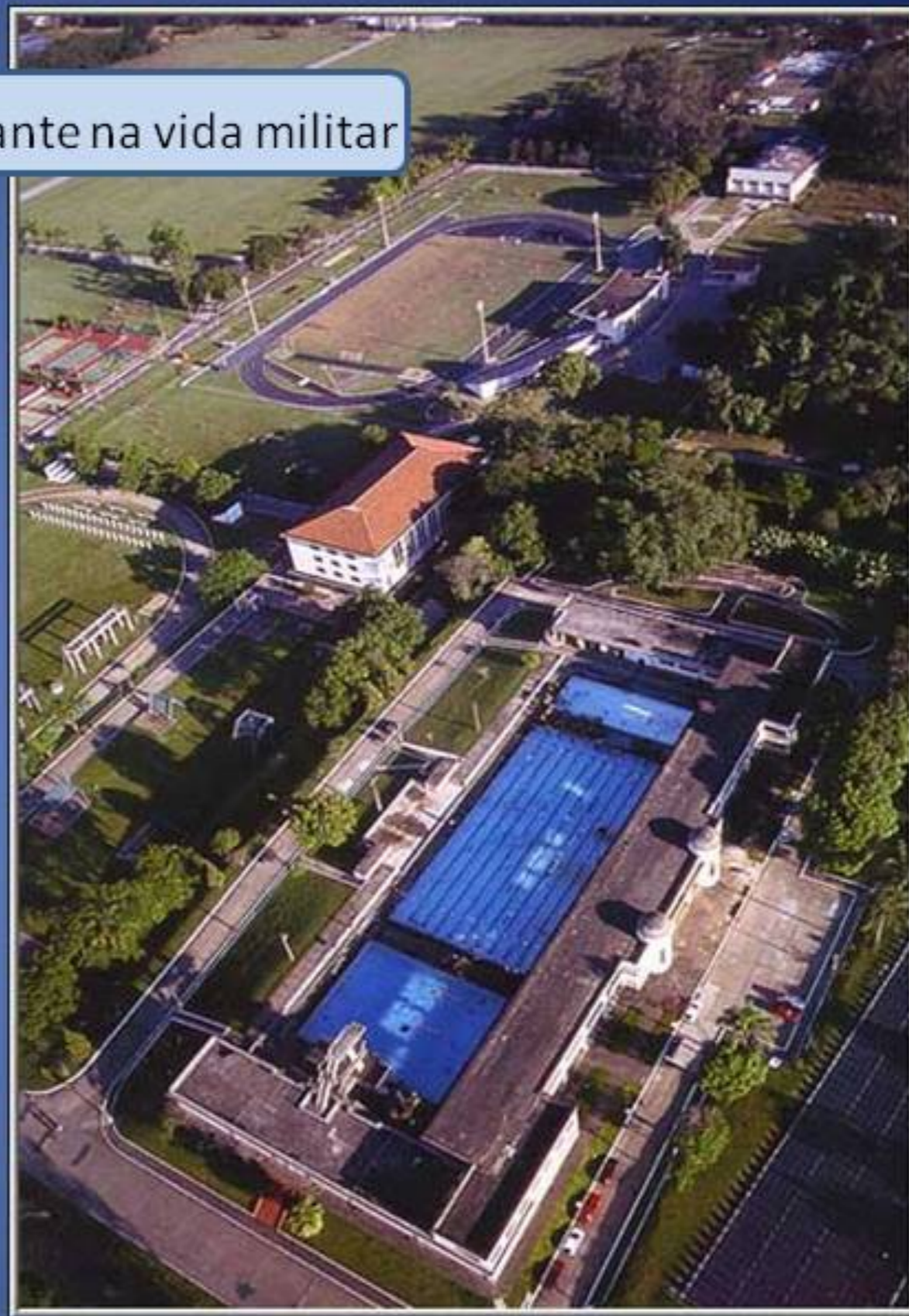
Instalações do Dpto de Ed Física
